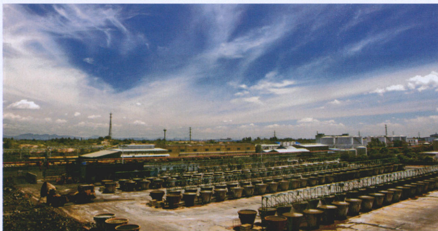
江西铜业集团20万吨/年铅锌冶炼及资源综合利用工程高清全景图
